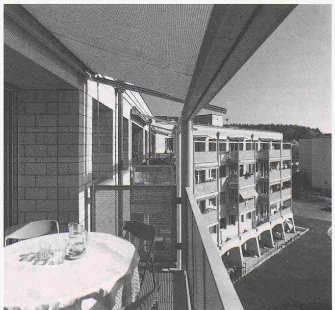
In La Grangette entstanden bisher 78 Wohnungen (Architekt: Atelier Fonso Boschetti, Lausanne) (Bild: F. Bertin)
