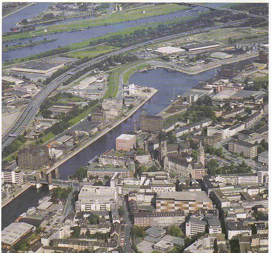
Duisburg, Hafenanlagen und Rhein-Herne-Kanal: Untergenutzte Häfen und Hafengebäude werden umgenutzt (Luftbild des Kommunalverbandes Ruhrgebiet)
