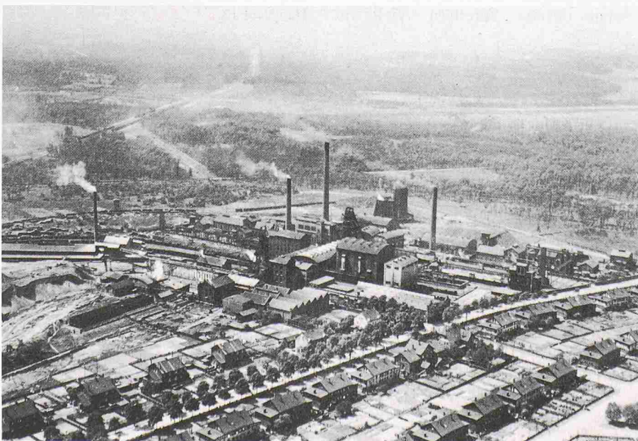
Recklinghausen, Zeche Recklinghausen II, 1926: Zechanlagen und die ihnen direkt zugeordneten Bergarbeitersiedlungen prägen seit dem letzten Drittel des 19. Jahrhunderts die Emscher-Region und zerstörten die Bruchwälder und die bäuerliche Kulturlandschaft (Luftbild des Kommunalverbandes Ruhrgebiet)
