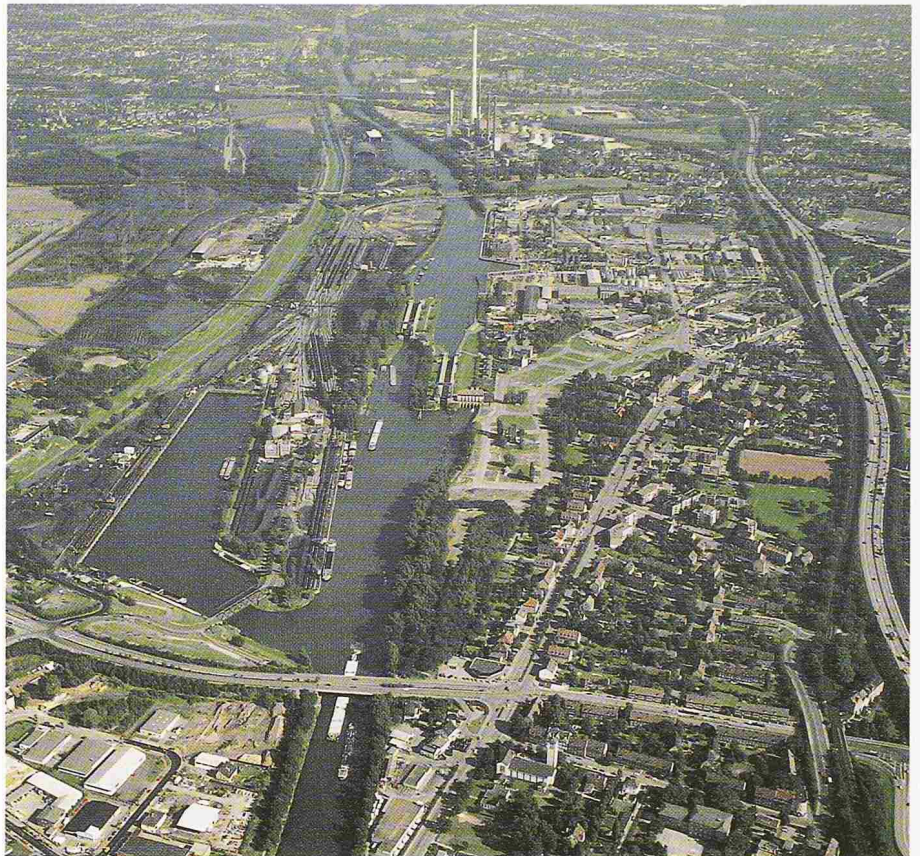
Herne-Crange, Rhein-Herne-Kanal mit Schleuse und Hafen: Untergenutzte Häfen, Industriebrachen und Kohlenlagerplätze stellen wichtige Flächenpotentiale für die Rückgewinnung von Freiraum und eine Aktivierung der Kanalufer für Freizeitnutzungen dar (Luftbild des Kommunalverbandes Ruhrgebiet)
