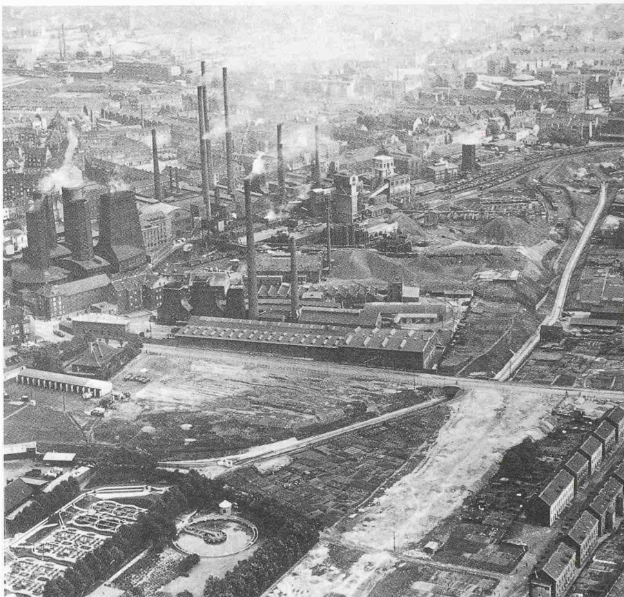
Essen-Nordstadt, 1927: Nebeneinander von Zeche, Kokerei und Wohnblocks als Folge einer ungeplanten Siedlungsentwicklung. Bergsenkungen, ungeordnete Aufhaltungen und als Abwassersammler kanalisierte Bachläufe prägen bis heute weite Teile der Emscher-Region (Luftbild des Kommunalverbandes Ruhrgebiet)
