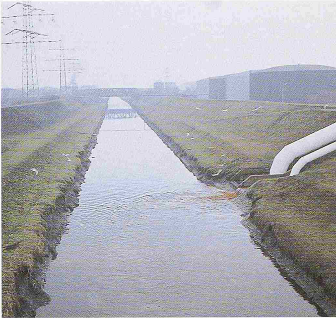
Abwassereinlauf in die Emscher, die im Rahmen der IBA Emscher Park ökologisch umgestaltet werden soll (Foto: IBA Emscher Park)
