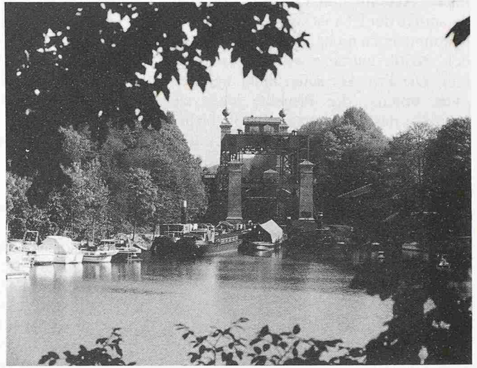
Schiffshebewerk Heinrichenburg, Schleusenpark Waltrop: Ausflugspunkt im Emscher Landschaftspark mit vier Generationen von verschiedenen Schiffshebewerken und Schleusen, die als Baudenkmäler erhalten bleiben (Foto: IBA Emscher Park)
