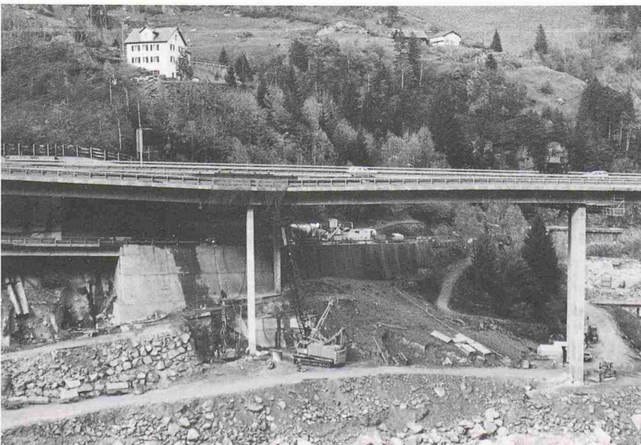
Bild 3. Stützmauersicherung mit Jet-Säulen (Situation)
