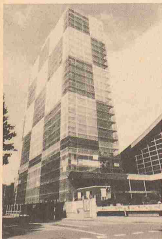
Beim Kongresshaus Biel werden Gerüstschutznetze zum Kunstobjekt
