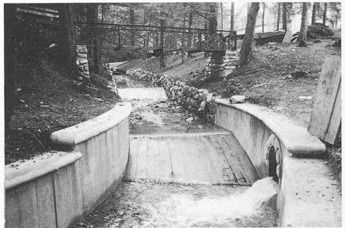
Bild 16. Die Unterhaltsstrecke am Wissenbach nach Ende der Sanierungsarbeiten 1987. Die Ufermauer rechts im Bild ist mit Spritzbeton aufprofiliert, die linke vollständig erneuert worden. Die Rampen aus Eichenholz sind in Anlehnung an frühere Bauverfahren rekonstruiert worden.
