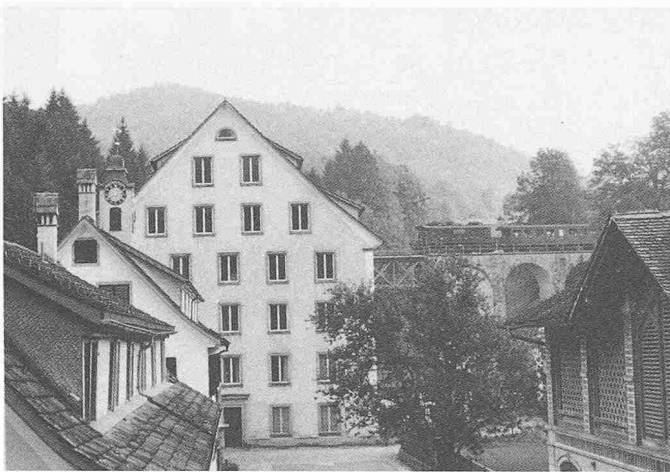
Bild 11. Das Industrieensemble in Neuthal bei Bäretswil mit dem ehemals als Spinnerei genutzten Fabrikgebäude und dem Fabrikantenwohnhaus mit dem kleinen Zeitturm. Im Hintergrund der Eisenbahnviadukt über das Tal des Wissenbachs, mit einer (bereits wieder historischen) Elektrolokomotive des Dampfbahn-Vereins Zürcher Oberland.
