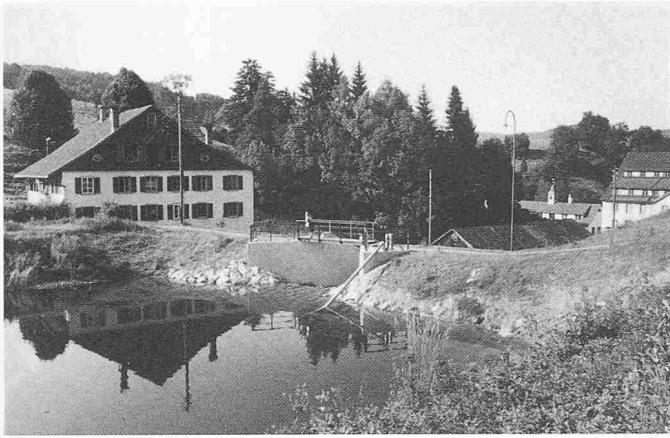
Bild 19. Erddamm Unterer Weiher nach der Sanierung im August 1989 mit der ehemaligen Mühle Müedsbach, rechts davon im Hintergrund das ehemalige Fabrikantenwohnhaus und Fabrikgebäude.
