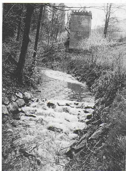
Bild 17. Neuer Uferschutz mit Blockrampe am Wissenbach. Die Konstruktion mit Blöcken entspricht den neuen Erkenntnissen des naturnahen Gewässerausbau. Im Hintergrund der Turbinenturm der Seiltransmission.
