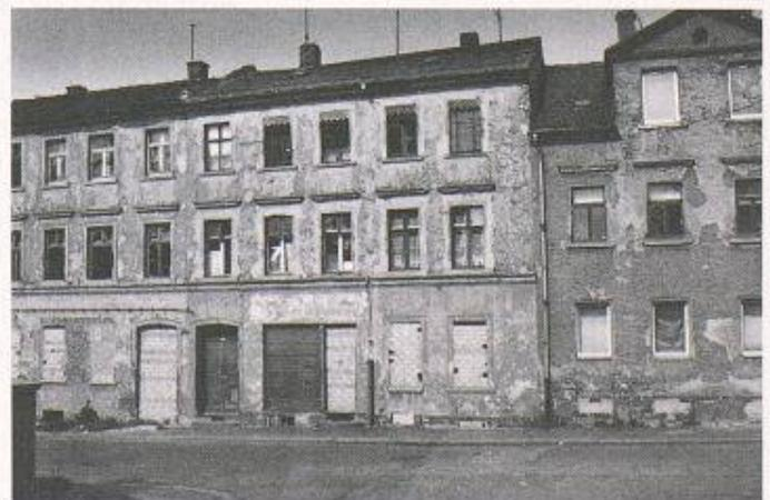
Bild 2. Mangel an Unterhalt infolge unrealistisch tiefer Mietzinsse hat einen beispiellosen Zerfall der Bausubstanz bewirkt. Undichte Dächer lassen zunächst die oberen Geschosse unbewohnbar werden; mit der Zeit schreitet die Aushöhlung weiter nach unten fort, bis schliesslich der ganze Bau aufgegeben werden muss
