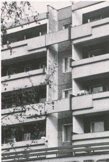
Bild 3. «Sozialistische» Neubauwohnungen – häufig ein lebensgefährlicher Pfusch! Nachdem bei diesem Wohnblock eine vorfabrizierte Balkonbrüstung in die Tiefe fiel und einen schweren Unfall verursachte, wurden die übrigen Brüstungen behelfsmässig mit Klammern und Überbrückungsplatten gesichert
