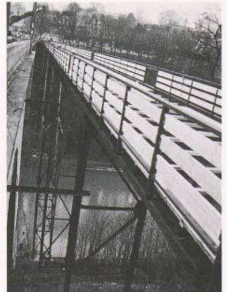
Der Fussgängersteg mit 180 m Länge läuft dicht neben der Lorrainebrücke (Bild: Senn AG)
