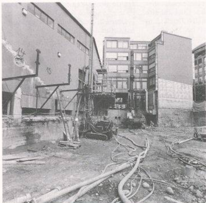
Bild 6. Bereich PAX-Gebäude: Jettinggeräte mit ihren Versorgungsleitungen im Einsatz
