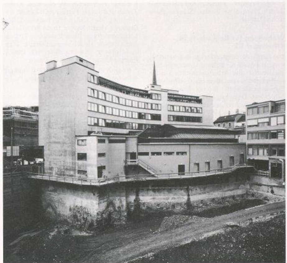
Bild 8. Bereich PAX-Gebäude: Freilegen der Soilcreteunterfangung
