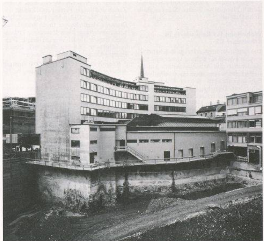
Bild 8. Bereich PAX-Gebäude: Freilegen der Soilcreteunterfangung
