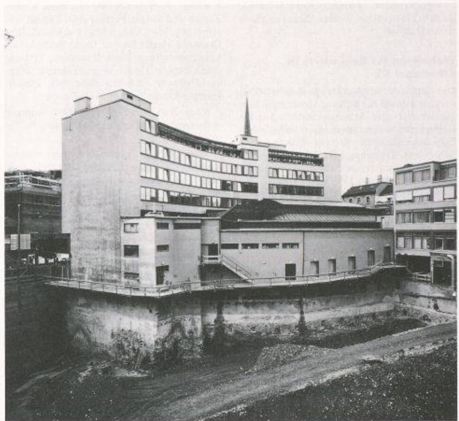
Bild 8. Bereich PAX-Gebäude: Freilegen der Soilcreteunterfangung
