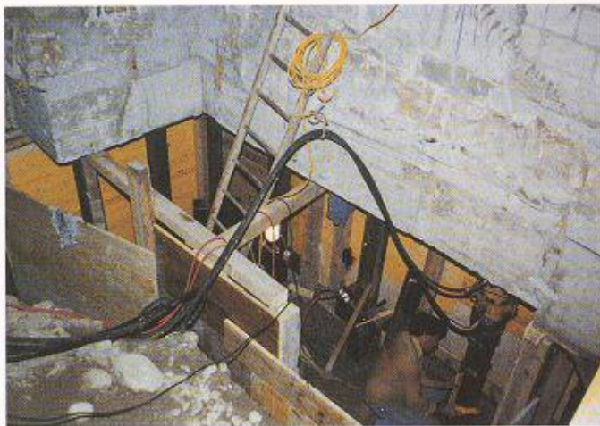
Bild 2. Unterfangen der Pfeiler- und Wandfundamente mit Presspfählen
