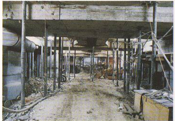
Bild 5. Aushub im 2. Untergeschoss für die Passage Bahnhofstrasse. Im Bild sichtbar die von oben erstellten Mikropfähle, welche die Decke stützen (Decke mit Unterzügen und untergehängten Elektrotrassees)
