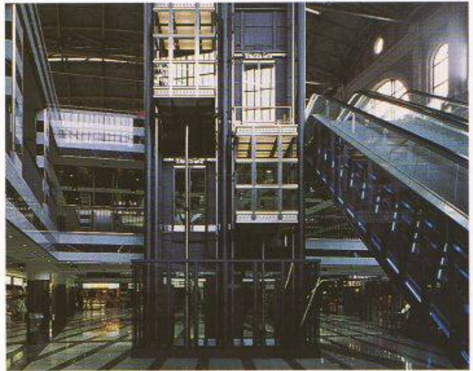
Bild 4. Liftturm und grosse Rolltreppen vom 2. Untergeschoss zur Haupthalle
