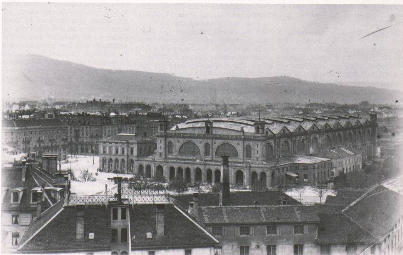
Bild 4. 1871 realisierter Bau von Jakob Friedrich Wanner mit kleinem Annexbau und stehengelassenem Betriebsgebäude des ersten Bahnhofs (von Architekt Wegmann 1847)
