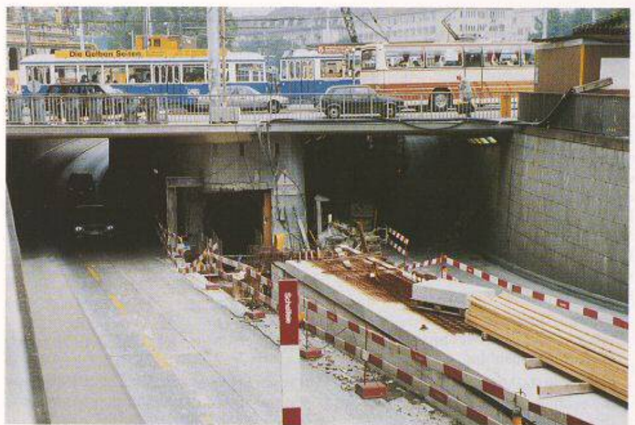
Bild 6. Kanal und Endschaft des Pressrohrvortriebs in der Unterführung des Bahnhofquais vor dem Zusammenschluss (in Fliessrichtung gesehen)
