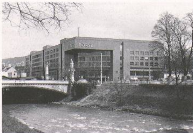
Der Eingangsbereich zur neuen Börse liegt gegenüber der Stauffacherbrücke an der Sihl. Hier liegt ganz rechts das Gelände des ehemaligen Bahnhofes Selnau, auf dem eine Wohnüberbauung entstehen soll
