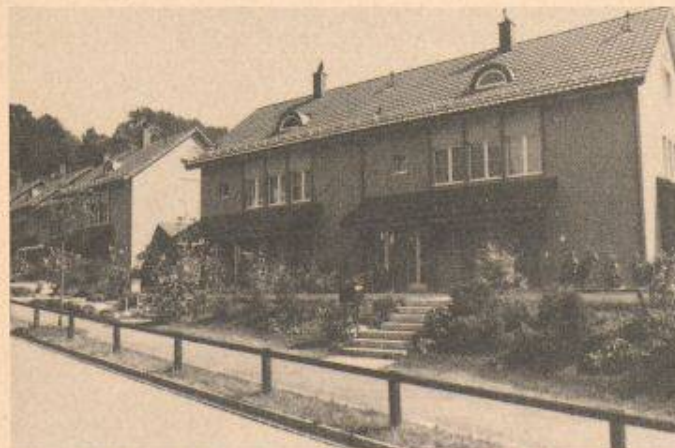
Bei der Wohnsiedlung in Freienstein ZH wird mittels Integral-Wärmepumpen die Erdwärme genutzt
