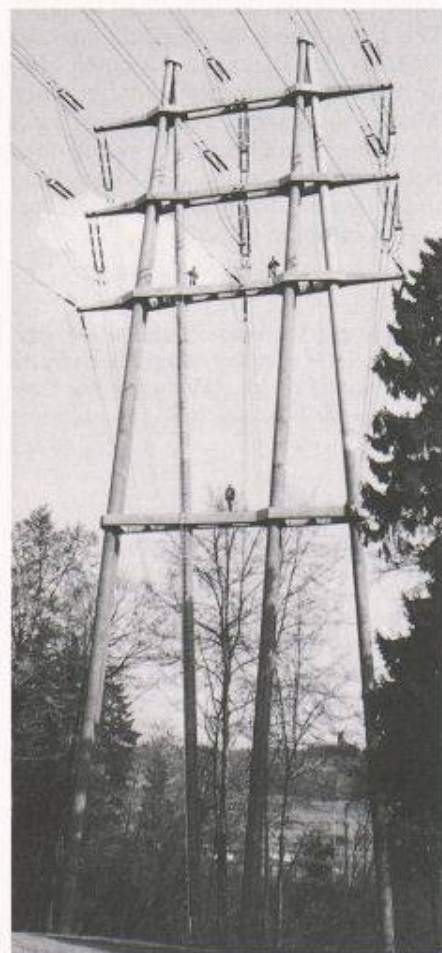
Bild 1. Der höchste Betonfreileitungsmast Europas (59,5 m Höhe)
