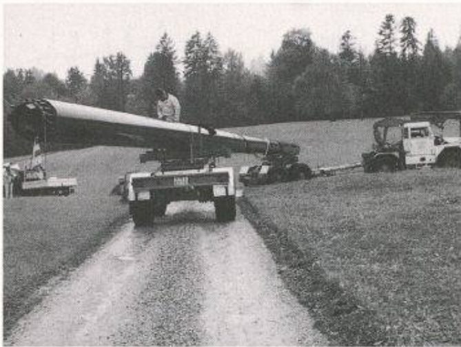
Bild 4. Transport der Mastteile
