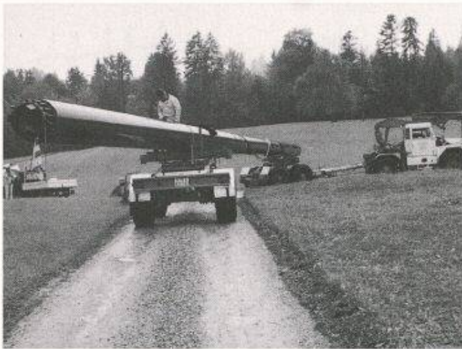
Bild 4. Transport der Mastteile
