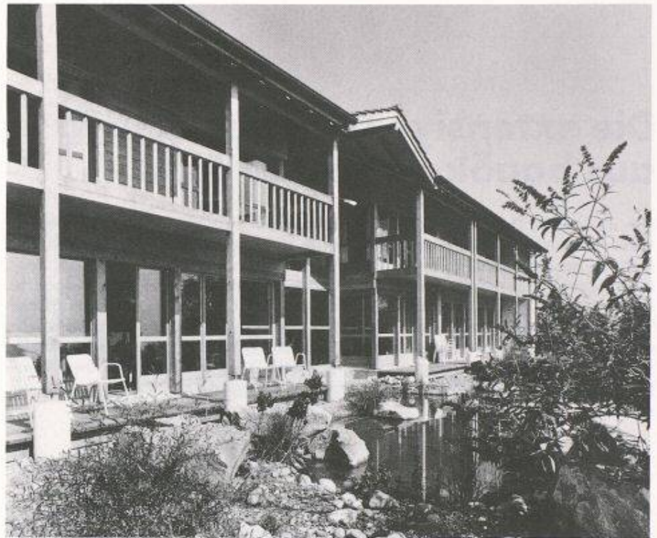
Bild 6. Wohnhaus in St. Niklausen (Architekt: Paul Roos). Auf drei Seiten Mauern aus Backstein mit möglichst wenigen Fenstern, gegen Süden geöffnet der eingeschobene reine Holzbau aus Fichtenholz.
