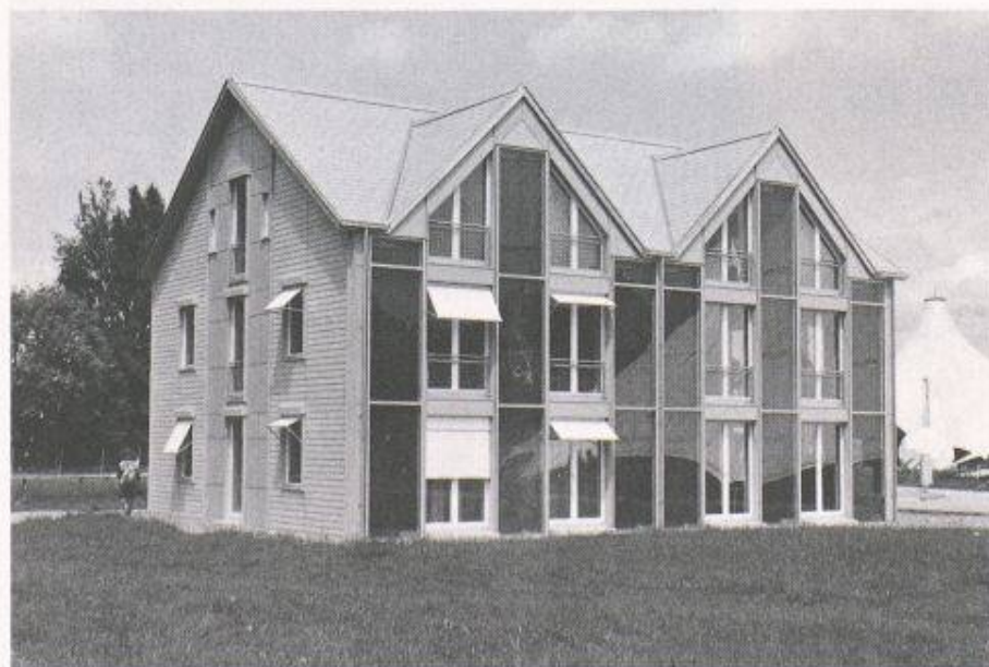
Bild 3. Null-Energie-Haus an der Heureka. Die in der Fassade integrierten Kollektoren sind mit 10 cm dicker Transparenter Isolation abgedeckt
