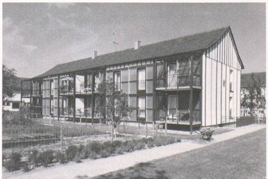
Bild 5. Mehrfamilienhaus Sonnenackerweg, Freiburg (BRD) mit 120 m 2 passiver TI-Fassade (Foto: Fraunhofer Institut für Solare Energiesysteme, Freiburg (BRD))
