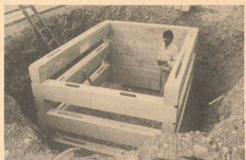
Pflanzgrube, erstellt aus Arconda-Norm-Pflanzgruben-Elementen
