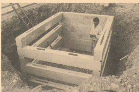
Pflanzgrube, erstellt aus Arconda-Norm-Pflanzgrubenelementen
