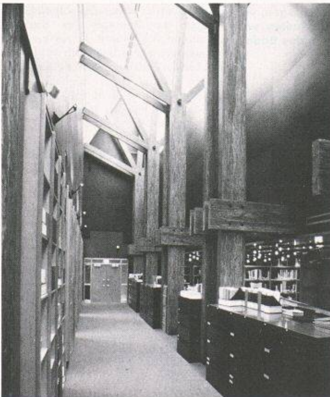
Bild 5. Parallam in einem mehrgeschossigen Forschungsbauwerk
