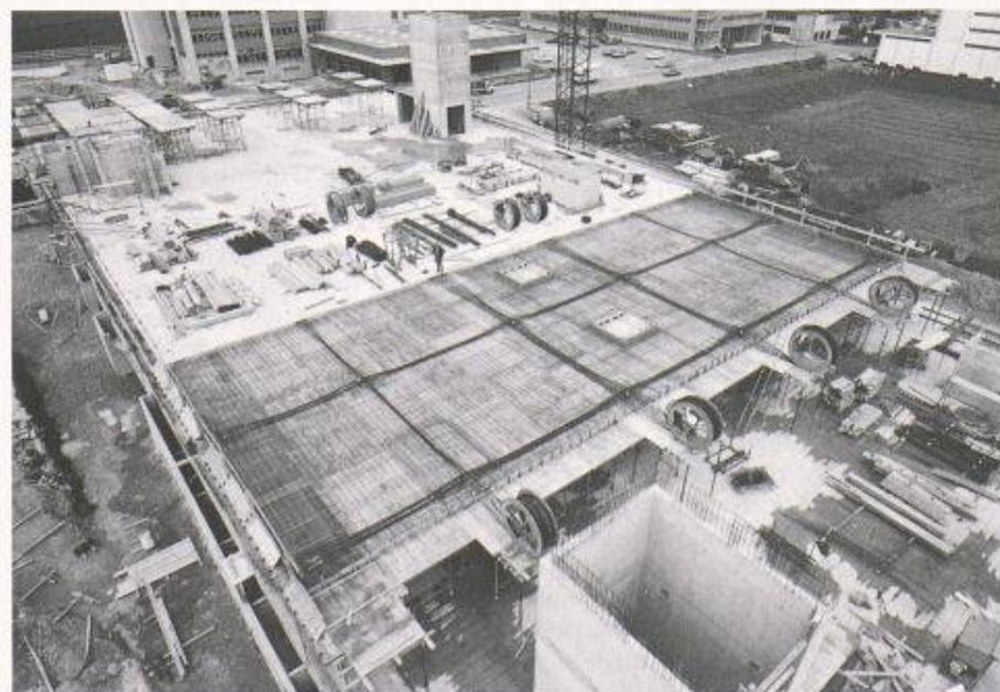
Bild 2. Vorgespannte Flachdecke
