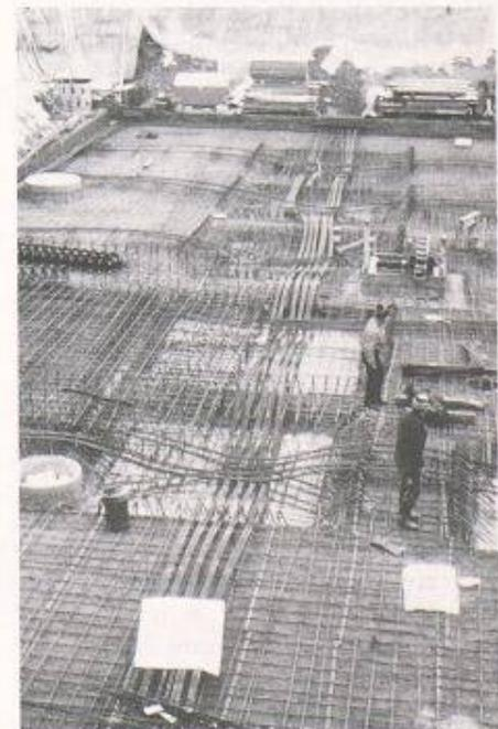
Bild 6. Vorgespannte Fundamentplatte
