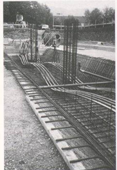
Bild 5. Vorgespannter Fundamentstreifen
