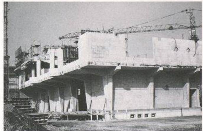
Bild 14. Vorgespannte Winkelstützen zur Unterstützung der Auskragung
