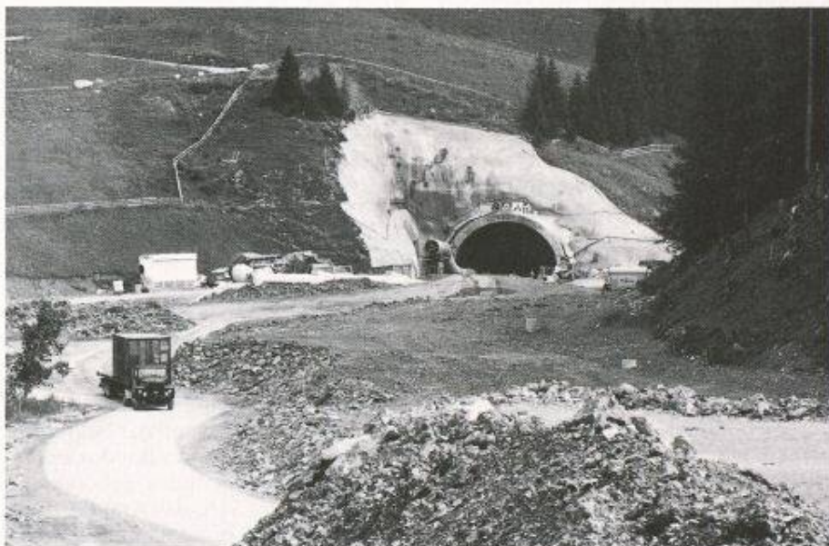
Im Bild das Nordportal des Vereinatunnels bei Klosters in Prättigau (Bild: Comet)
