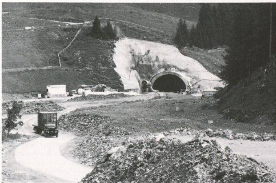
Im Bild das Nordportal des Vereinatunnels bei Klosters in Prättigau (Bild: Comet)
