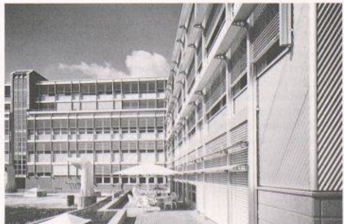
Bild 2. Büro- und Gewerbehau «Schwerzenbacherhof»
