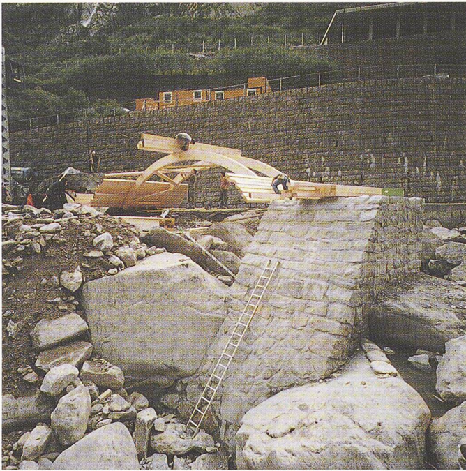
Bild 4. Hauptpfeiler auf drei Felsblöcken fundiert (Foto Aschwanden)
