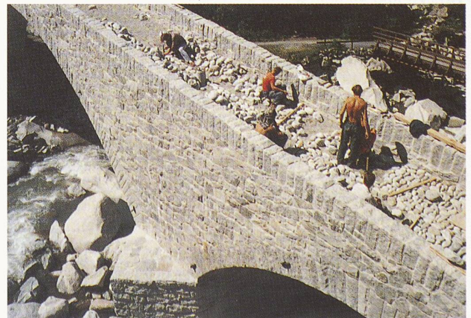
Bild 9. Einbau der Pflasterung aus gerundeten Steinen
