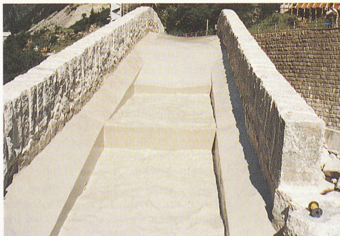
Bild 8. Detail Abdichtung (Foto P. Kurmann)
