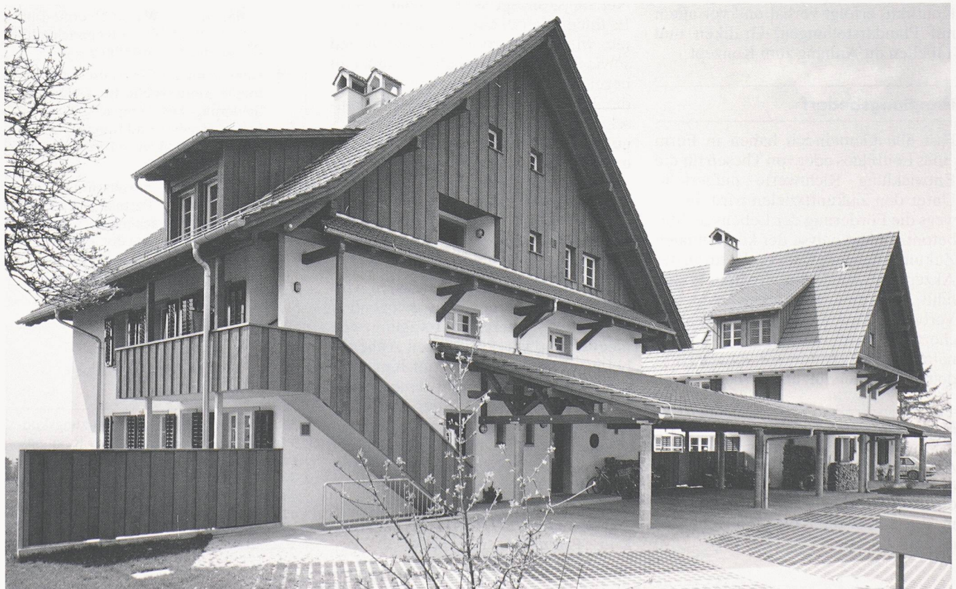
Bild 1. Die beiden giebelständigen Häuser mit nach Norden und Osten orientierten Fassaden: Das Haus rechts umfasst zwei Einfamilienhäuser, daneben die drei Maisonette-Wohnungen
