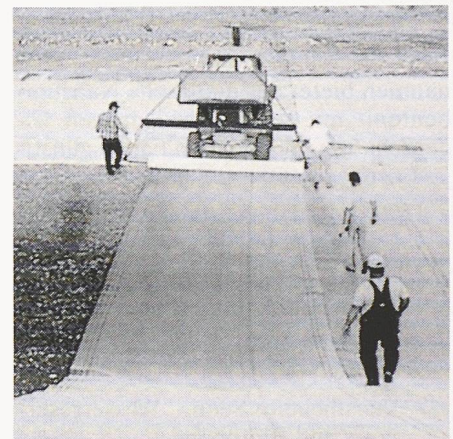
Verlegen einer Bentomat-Bahn
