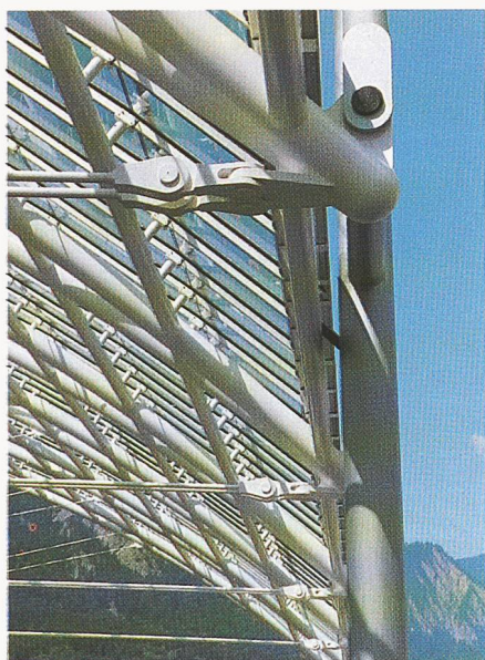
Bild 13. Anschlussdetail Zugbänder und Aufständering Dachhaut
