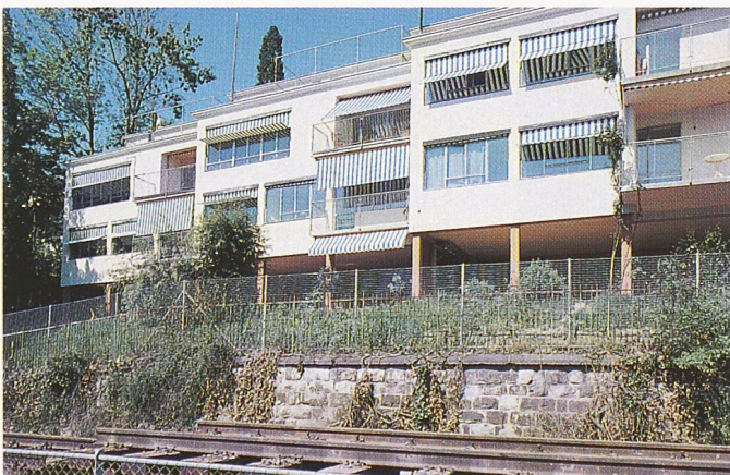
Bild 1. Reihenhäuser an der Wasserwerkstrasse in Zürich
