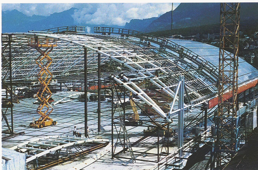
Bild 14. Montagezustand Hallendach
