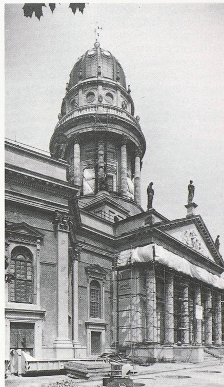
Restaurierungsarbeiten am Deutschen Dom am Berliner Gendarmenmarkt (Bild: BAM)
