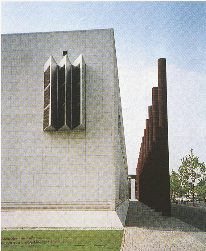
Südansicht. Eckausbildung mit Entlüftungskonstruktion, rechts die Friedrich-Ebert-Allee
