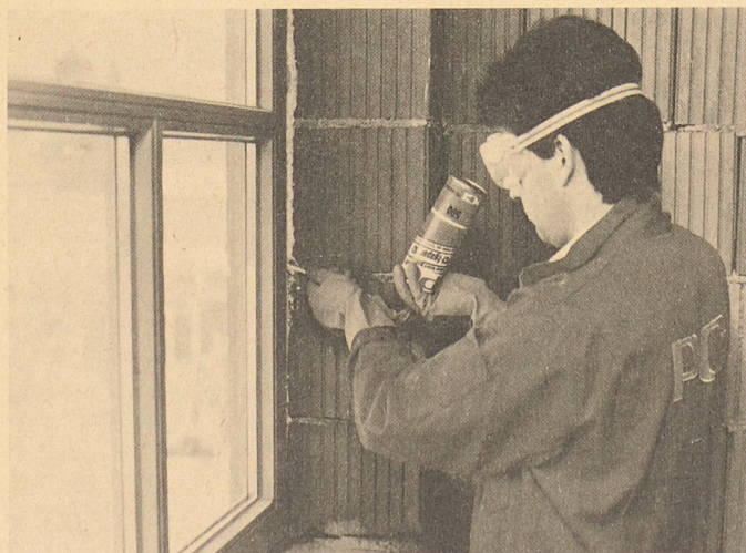
Das bei der Fenstermontage mit PCI-Egapor 93 verwendete Treibgas ist FCKW-frei
