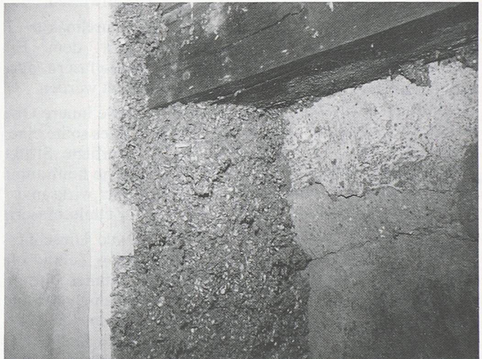
Bild 9. Einfamilienhaus Winterthur: Probeöffnung an der Außenwand; kompakte, dichte Anschlüsse der Zellulosefasern
