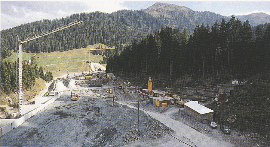
Bild 10. Bau- und Installationsstellen in Sagliains (Engadin)
