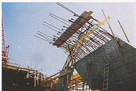
Bild 16. Gewindestäbe mit montierten Endverankerungen als obere Anschlussbewehrung der äusseren Portalrahmenecke (Foto: W. Maag)
