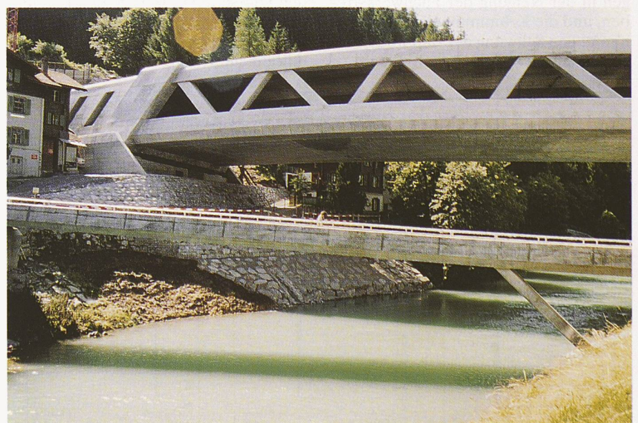
Bild 6. Fussgängerbrücke, Bahnbrücke und Verbindungsgalerie zum Zugwaldtunnel (Foto: W. Maag)
