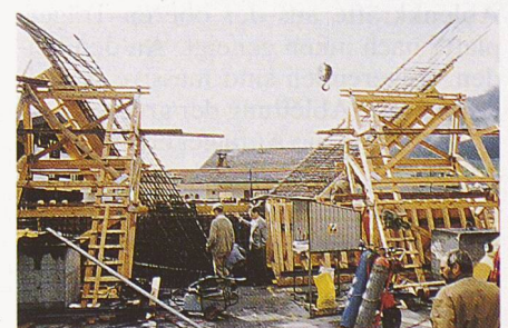
Bild 15. Zugstrebe mit 2'600 kN-Kabeln links, Druckstrebe mit Gewindestäben rechts (Foto: W. Maag)
