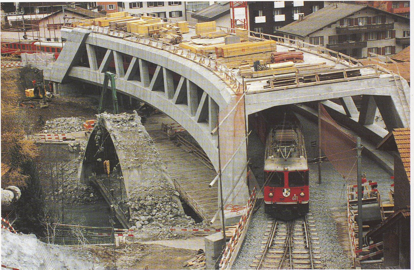
Bild 27. Zwischenphase mit provisorischem Bahnbetrieb durch die ausgeschobene Brücke, Abbruch der Bogenbrücke (Foto: U. Meier, AG Heinr. Hatt-Haller)
