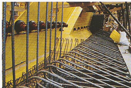
Bild 17. Mehrflächenverankerungen der 2'600 kN-Kabel im Portalrahmen auf der Kurvenaussenseite (Foto: W. Maag)
