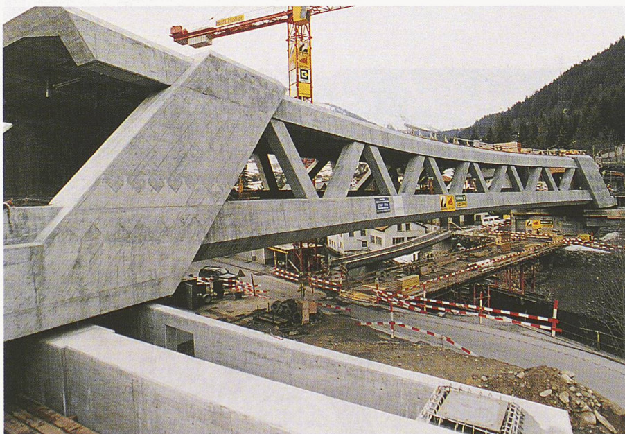
Brückeneinschub. Rechts die untere Platte des definitiven Widerlagers; in der Mitte das wiederum zur Dienstbrücke umgebaute Lehrgerüst und die fertig erstellte Fussgängerbrücke
