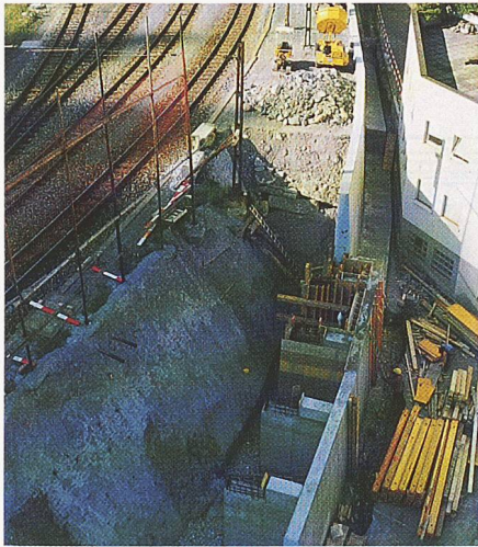
Beengter Platz für die Stützmauer «Coop» vor dem Bahnhof Klosters
