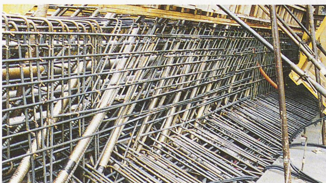
Randträger an Trogplatte; Details von Armierung/Vorspannung
