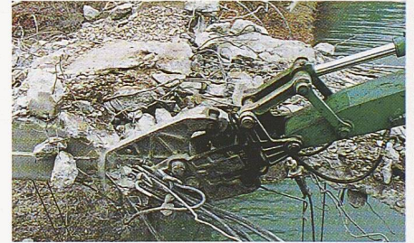
Brückenabbruch im November 92
