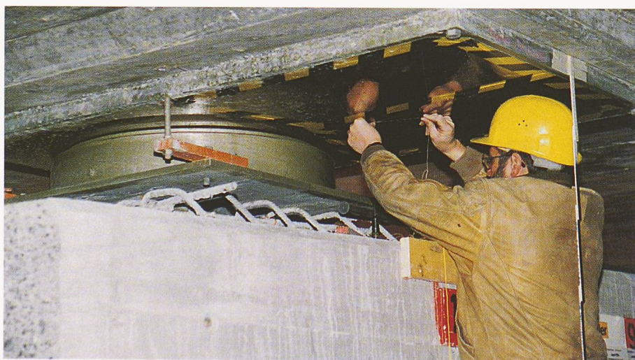
Bild 7. Millimetergenaues Ansteuern der Endlage bei Verschubmeter 10,00 (Foto: Zschokke)
