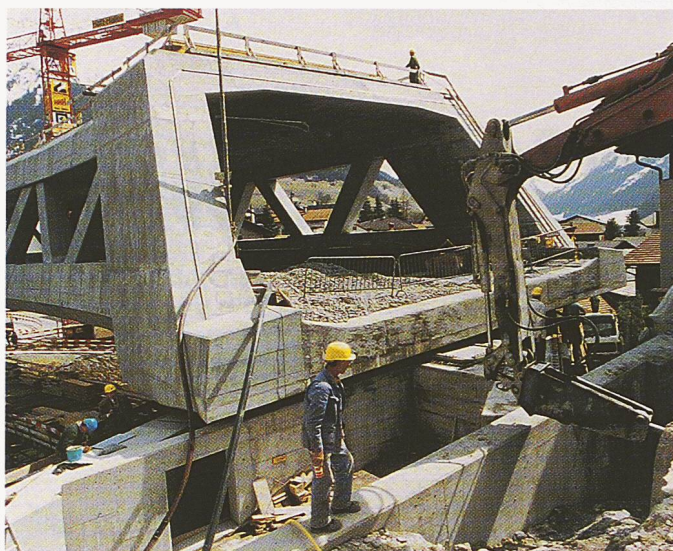
Bild 6. Brückenträger während Querverschub; auf der Querverschubbahn erfolgt das Umsetzen der teflonbeschichteten Neopreneplatten (Foto: Zschokke)
