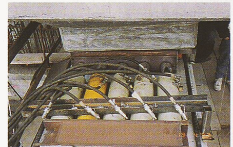
Bild 3. 5 x 800 kN-Pressen übertragen die Verschubkraft auf das kurvenäussere Taktshublager (Foto: F. Gruber)
