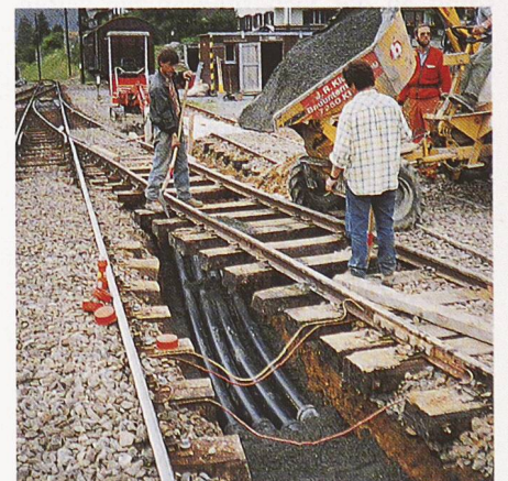
Bild 7. Auch einfachere Bauarbeiten sind im Bahnbetrieb behindert
