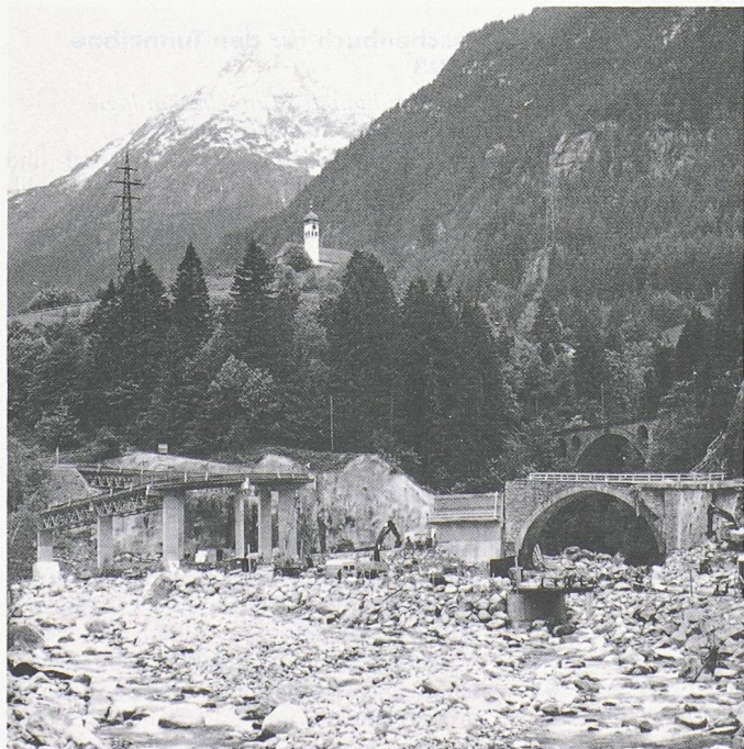
Naturkatastrophen richten immer wieder verheerende Verwüstungen an, die Sofort- wie auch längerfristige Bewältigungsmassnahmen erfordern. Im linken Bild die zerstörte Strassenbrücke zwischen Gurtellen und Wassen, als 1987 die Reuss nach schweren Unwettern zum reissenden Strom wurde und alles mit sich riss
