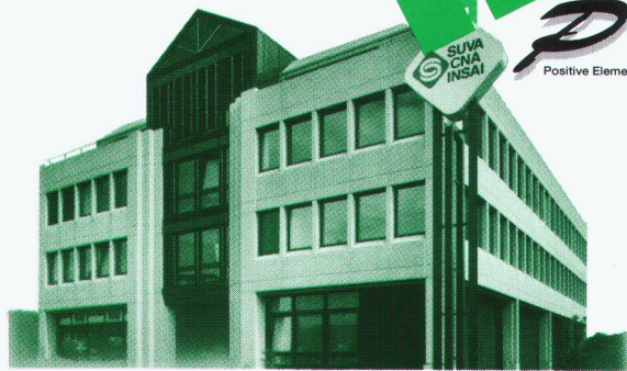
Geschäftshaus Adlikerkreuz, Regensdorf. Rötlich eingefärbte, sandgestrahlte Sandwich-Fassaden.
