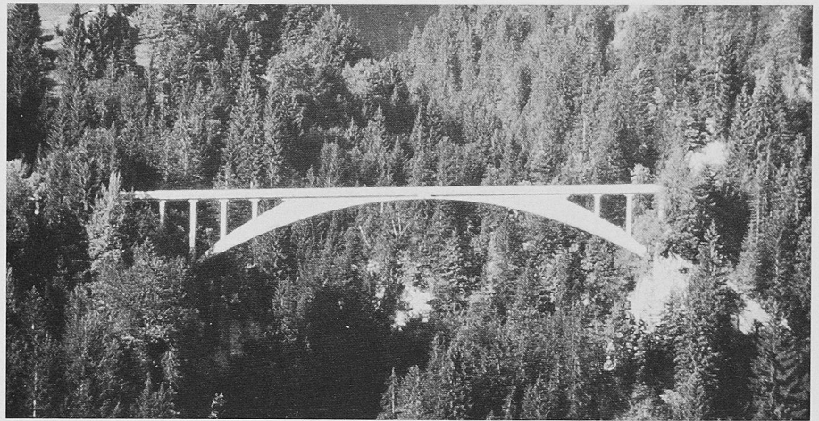
Bild 2. Salginatobel-Brücke, Spannweite 90 m, Baujahr 1930
