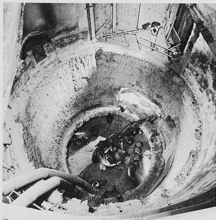
... und nach Beendigung der Abbauarbeiten am Beton des biologischen Schildes
