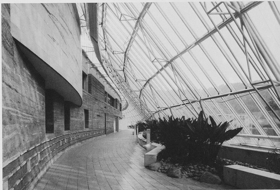
Bild 3. Die Schrägverglasung nutzt die passive Sonnenenergie. Die Fenster lassen sich automatisch von innen beschatten. Links die Lehmwand mit grosser Wärmespeicherfähigkeit. Das Raumklima wird zudem verbessert durch die Bepflanzung und einen kleinen Wasserlauf in der Brüstung
