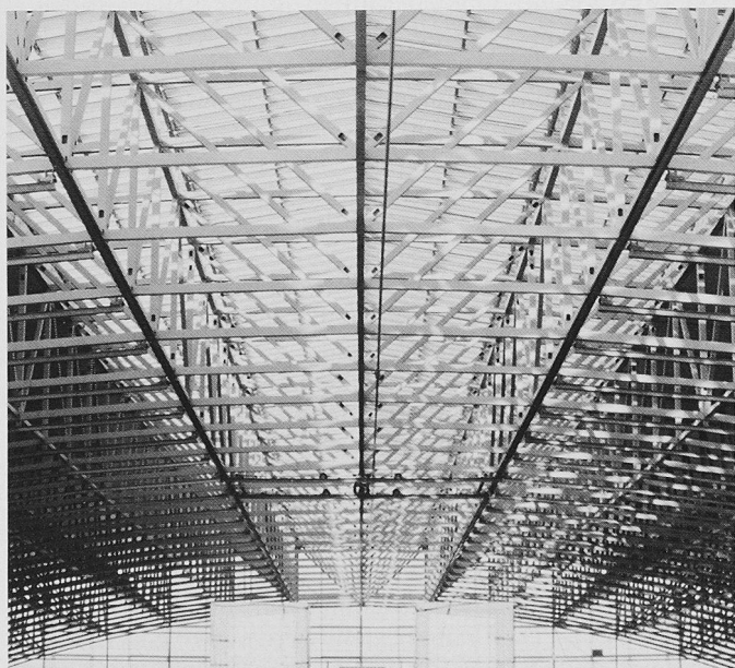
Bild 1. Frankfurt: 2400 t feuerverzinkter Stahl für die Dachkonstruktion
