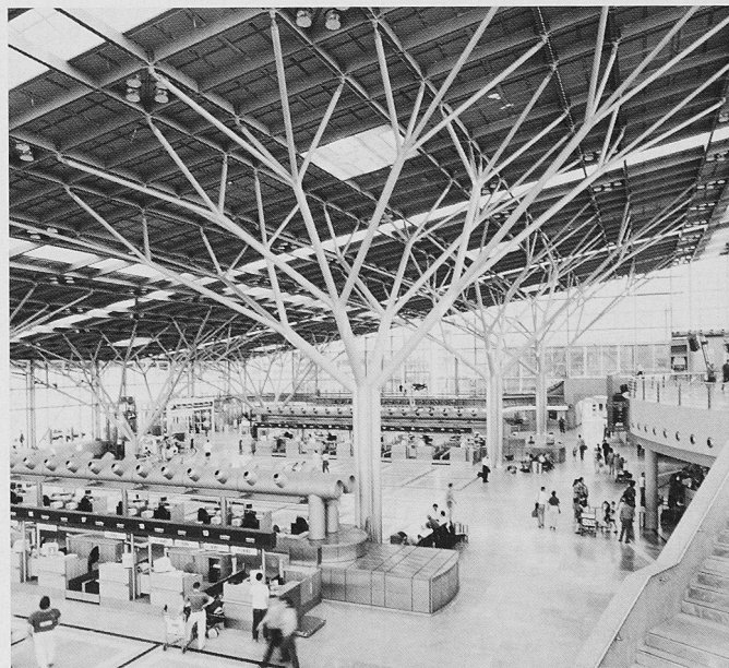
Bild 2. Stuttgart: filigrane Baumstützen aus Rundrohr im Flughafenterminal
