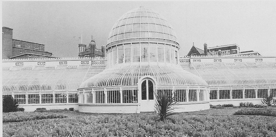
Palm House Belfast, 1839. Eines der ältesten Gewächshäuser in Gusseisen und Glas
