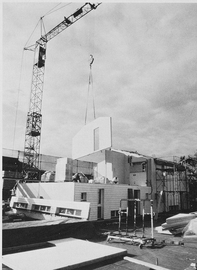
Bild 1. Montage eines Fassadenelementes eines Niedrigenergiehauses in Bremgarten. Vorfabrizierte Holztafeln ermöglichen ein Hochziehen in einem Tag
