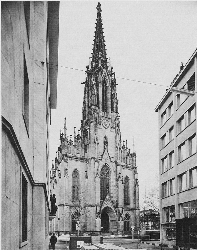
Ostfassade, Zustand nach der Restauration
