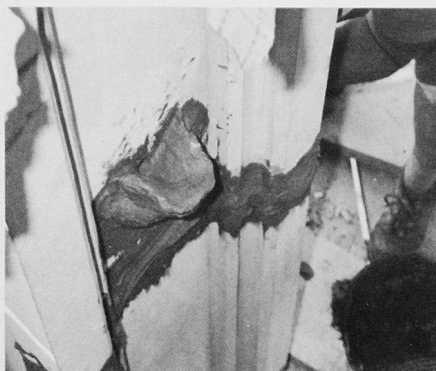
An die neue Fiale aus Oberkirchner Sandstein angeformtes sog. Schwalbennest zum Eingiessen des Bleis, darunter die mit Ton abgedichtete Horizontalfuge, damit das Blei nicht ausläuft; Einfüllen des Bleis; Verstemmen der mit Blei gefüllten Horizontalfuge
