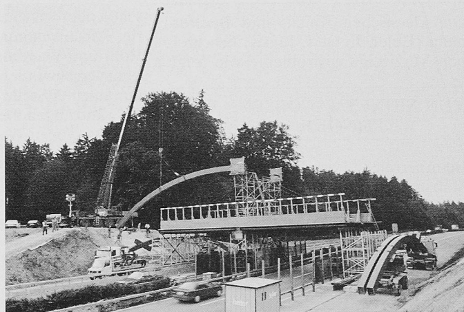
Bild 4. Montage der Stahlkonstruktion mit Autokran. Schutzgerüst über die vier Fahrspuren der N1
