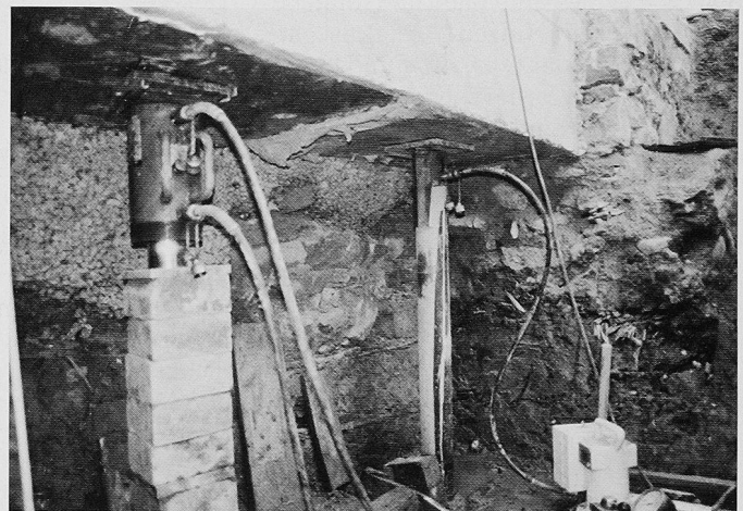
Bild 6. Press- und Injektionsbohrpfähle, Objekt Kirche Teufen
