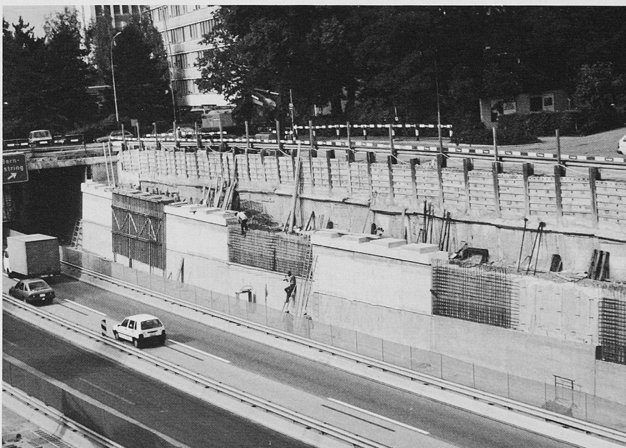
Bild 1. Die bestehenden Stützmauern werden für die neue Aufgabe angepasst (August 1990, Foto H. Müller)
