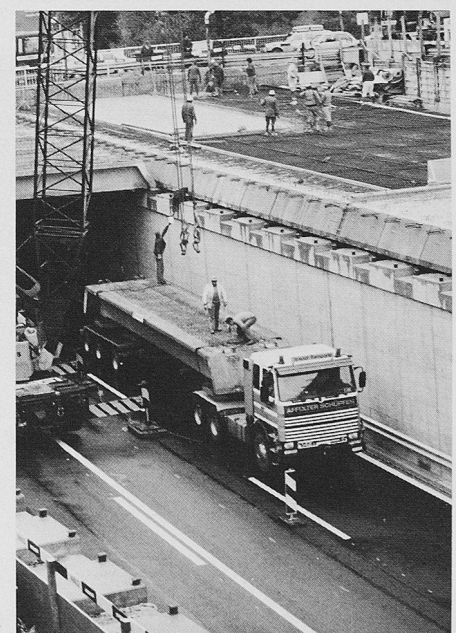
Bild 3. Vorfabrizierte Betonelemente werden montiert und mit dem Überbeton untereinander verbunden (November 1991, Foto H. Müller)
