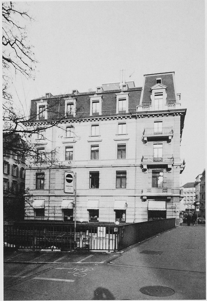
Fassade Schanzengraben: Kunststein im Erdgeschoss, Berner Sandstein in den Obergeschossen (Turm und Eckquader), Rillenputz in den Obergeschossen (Fassadenfelder)
