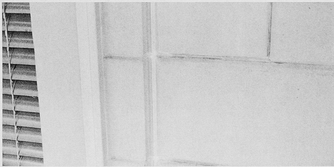
Bild 13. Schliessen von Fugen
