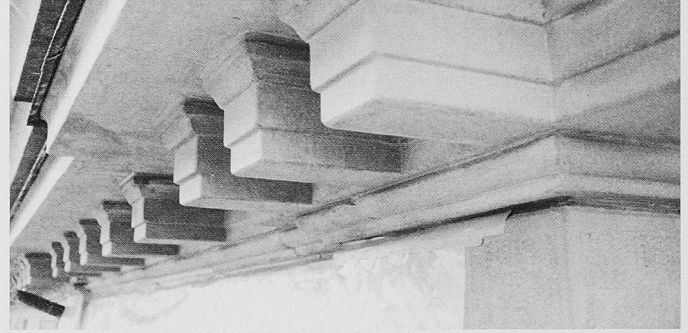
Bild 12. Überarbeiten von abblätternden Dachgesimsen
