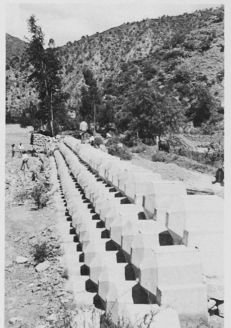
Bild 8/9. Die Uferschutzmauer nach Erreichen der vollen Höhe im Februar 1989 (Bilder: E. Decormis, Sucre)
